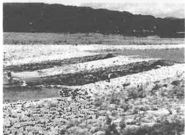
復元された大井手堰 戸立と野越からなり洪水を調節する。
