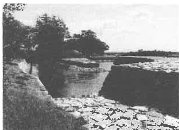
象の鼻つけ根の野越より天狗の鼻を見る 野越は象の鼻より1.5m低く、鼻先端部から流入する土砂を止める。
