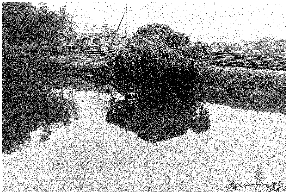
(1) 南側堤の状況（北西から）
