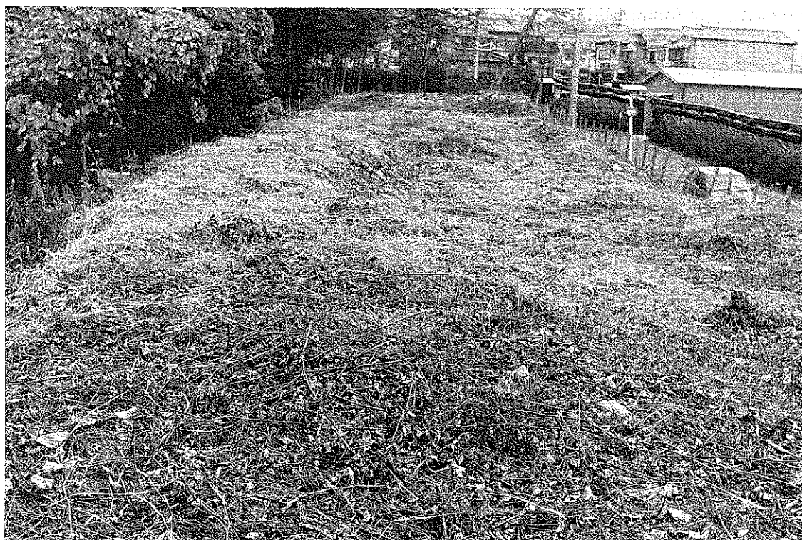
(2) 南側堤の状況（西から）
