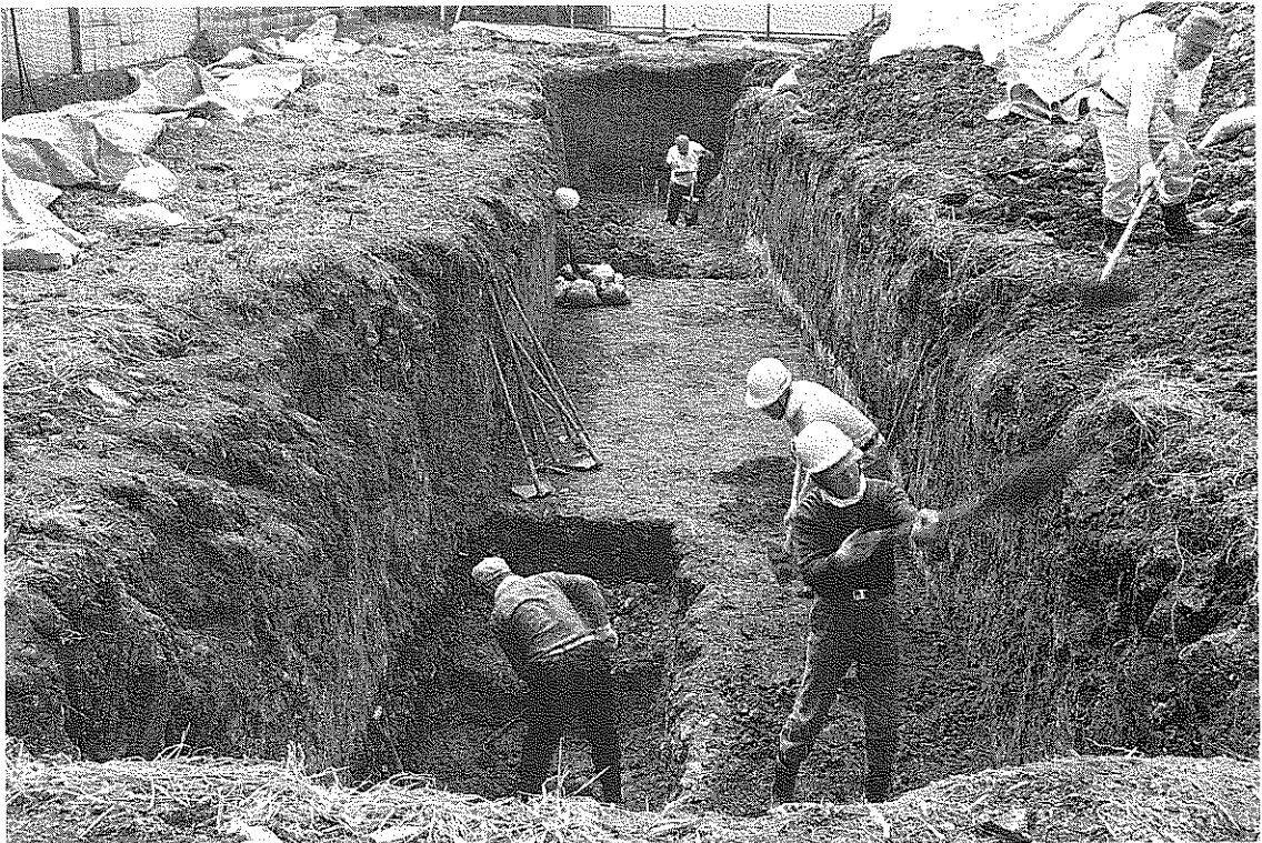
(2) 作業風景 (北から)
