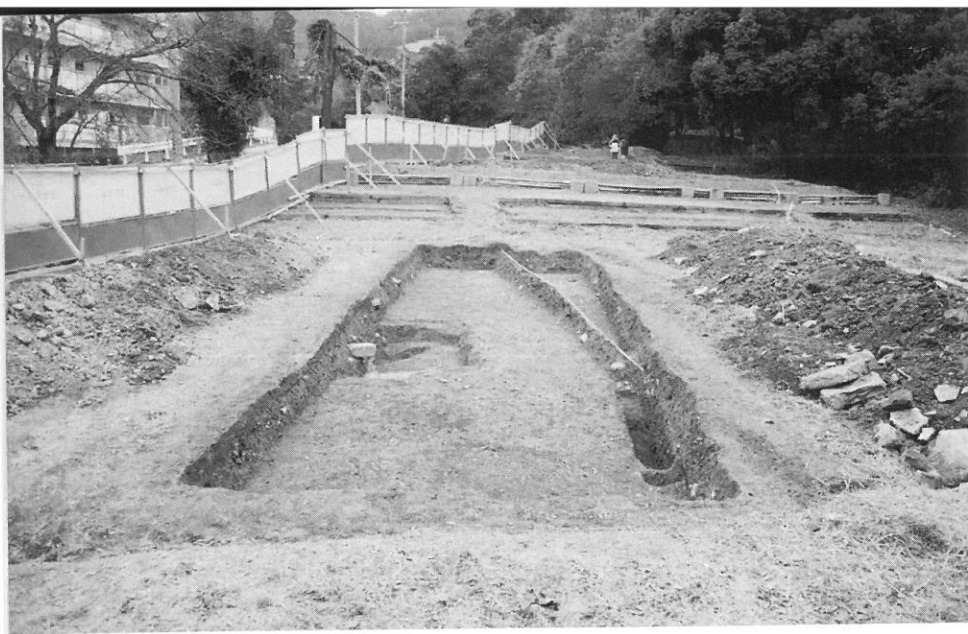
fig 6. 掘削終了の全景（西→東）
