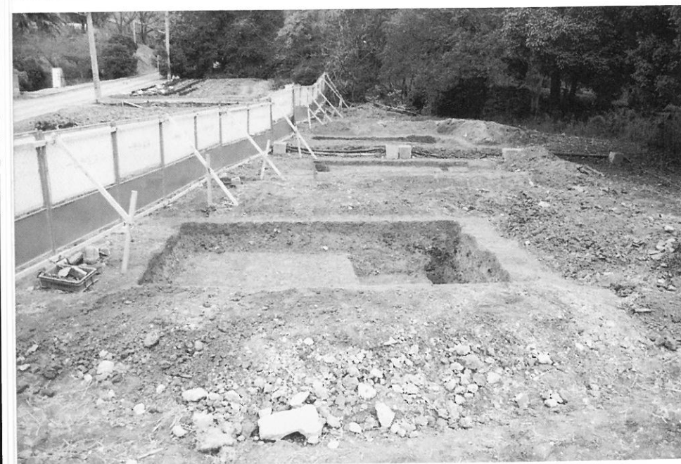
fig 8. 調査地東部の全景（西→東）
