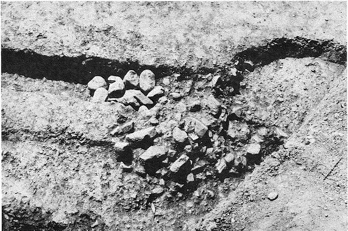
(2) 第3トレンチ SD13取水口閉塞状況 (南から)
