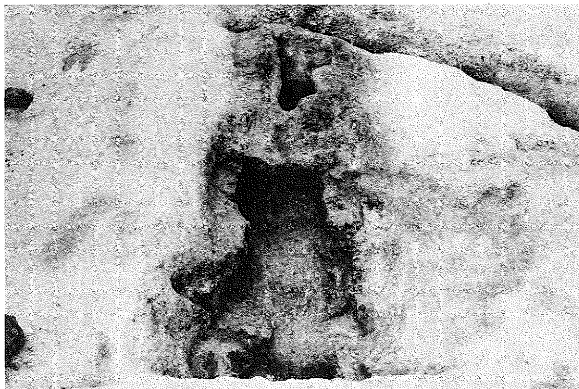
(2) 3号窯上半部天井崩落状況(南から)
