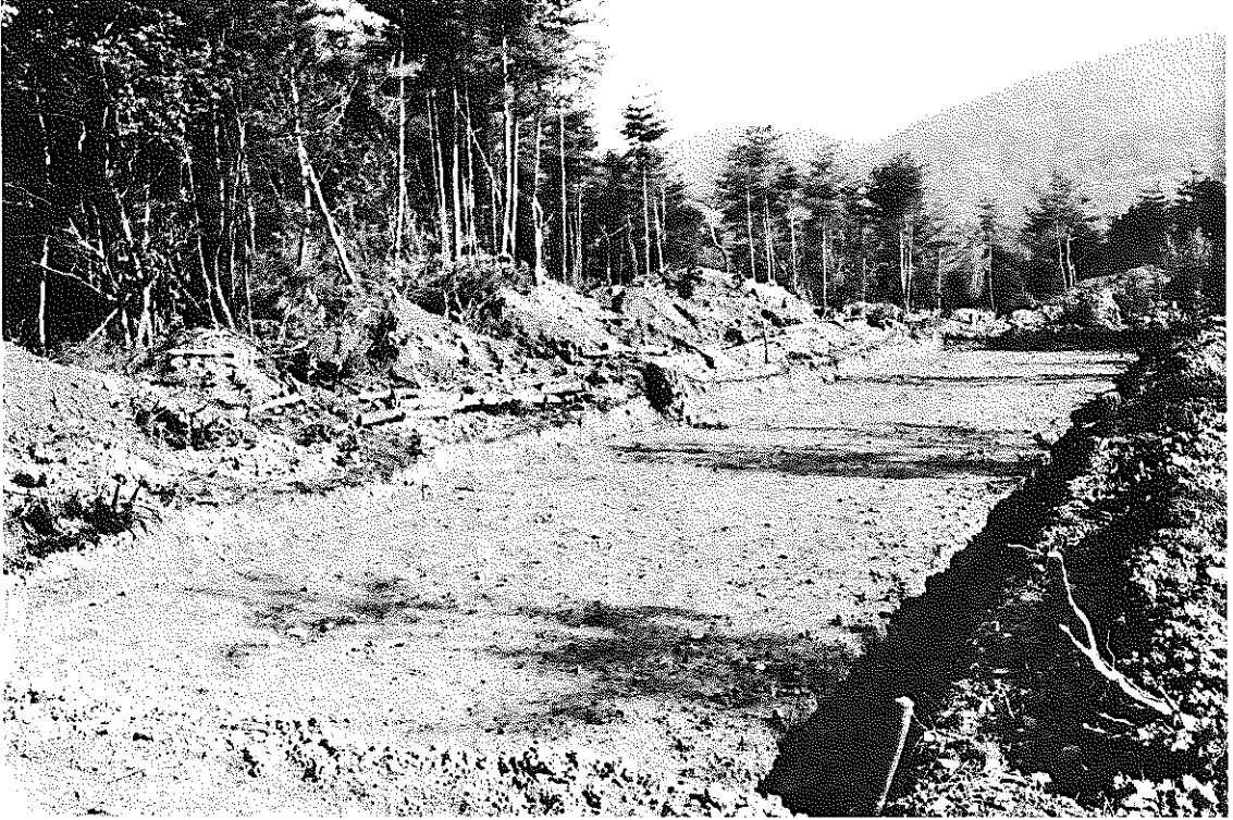
(1) 第9トレンチ (羽戸山遺跡) 完掘状況 (南西から)
