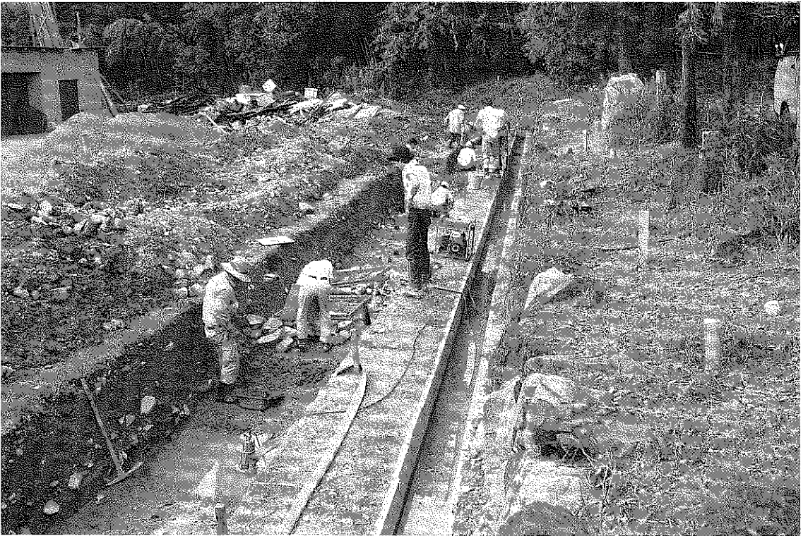
(2) 第3トレンチ調査風景 (南東から)
