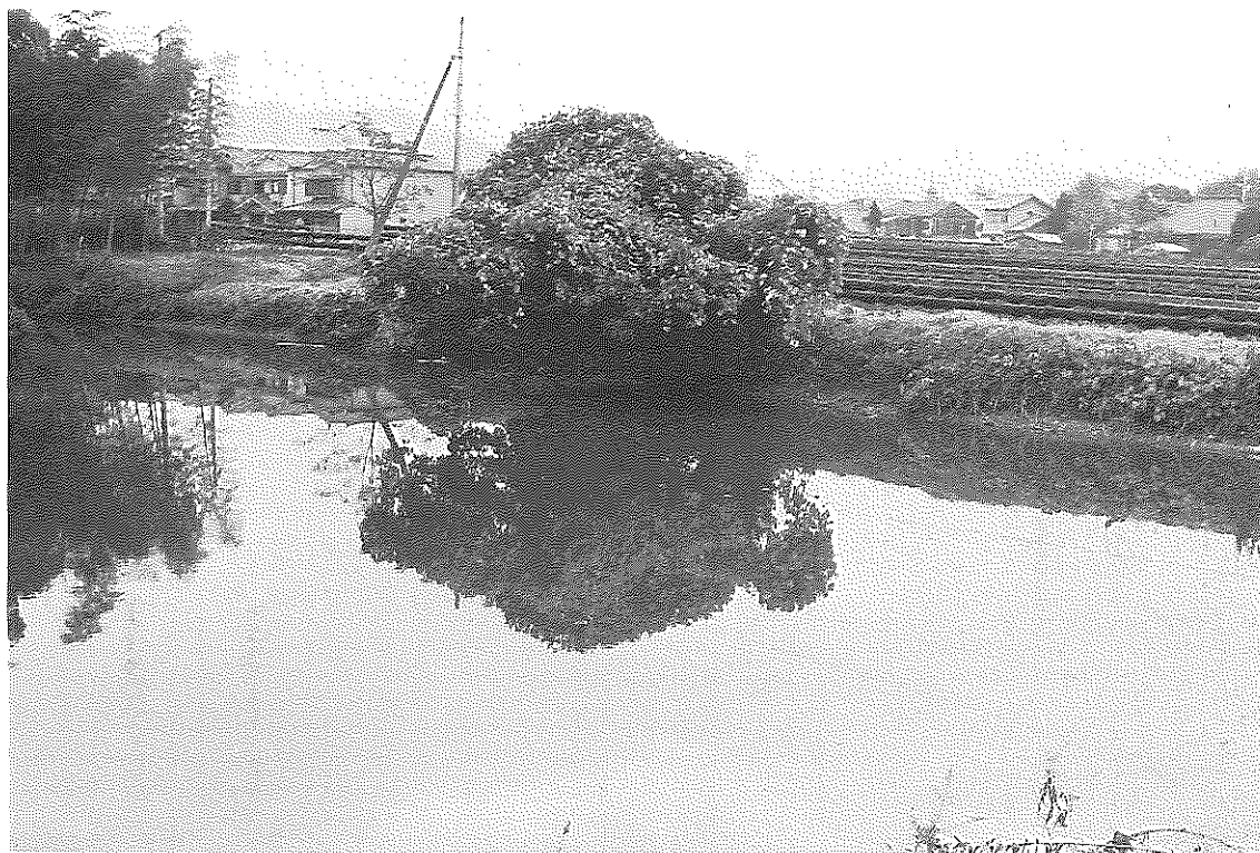
(1) 南側堤の状況（北西から）
