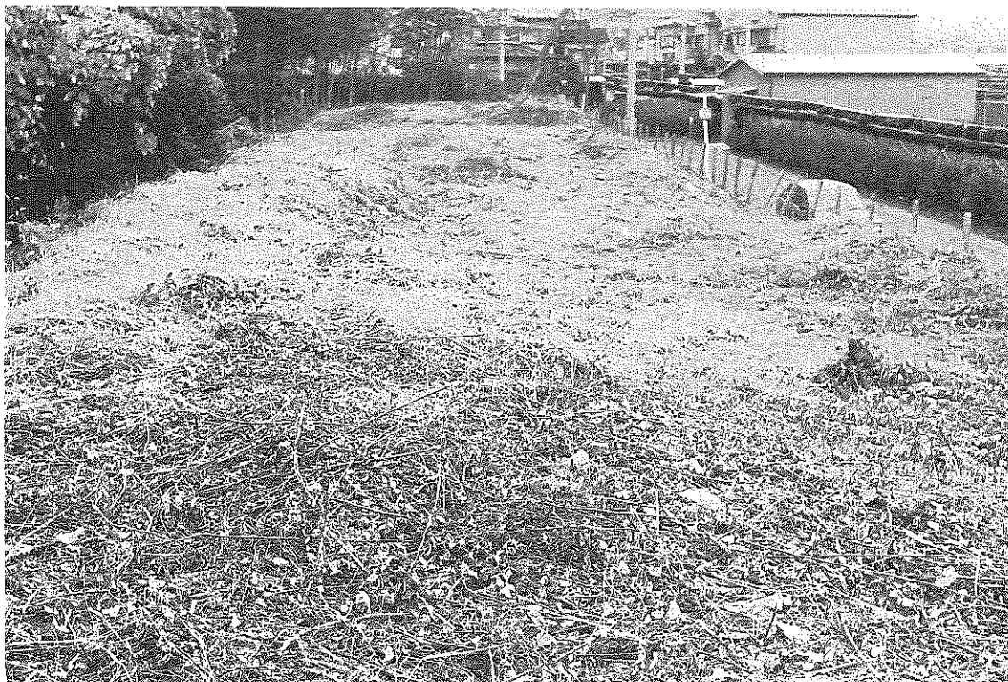
(2) 南側堤の状況（西から）
