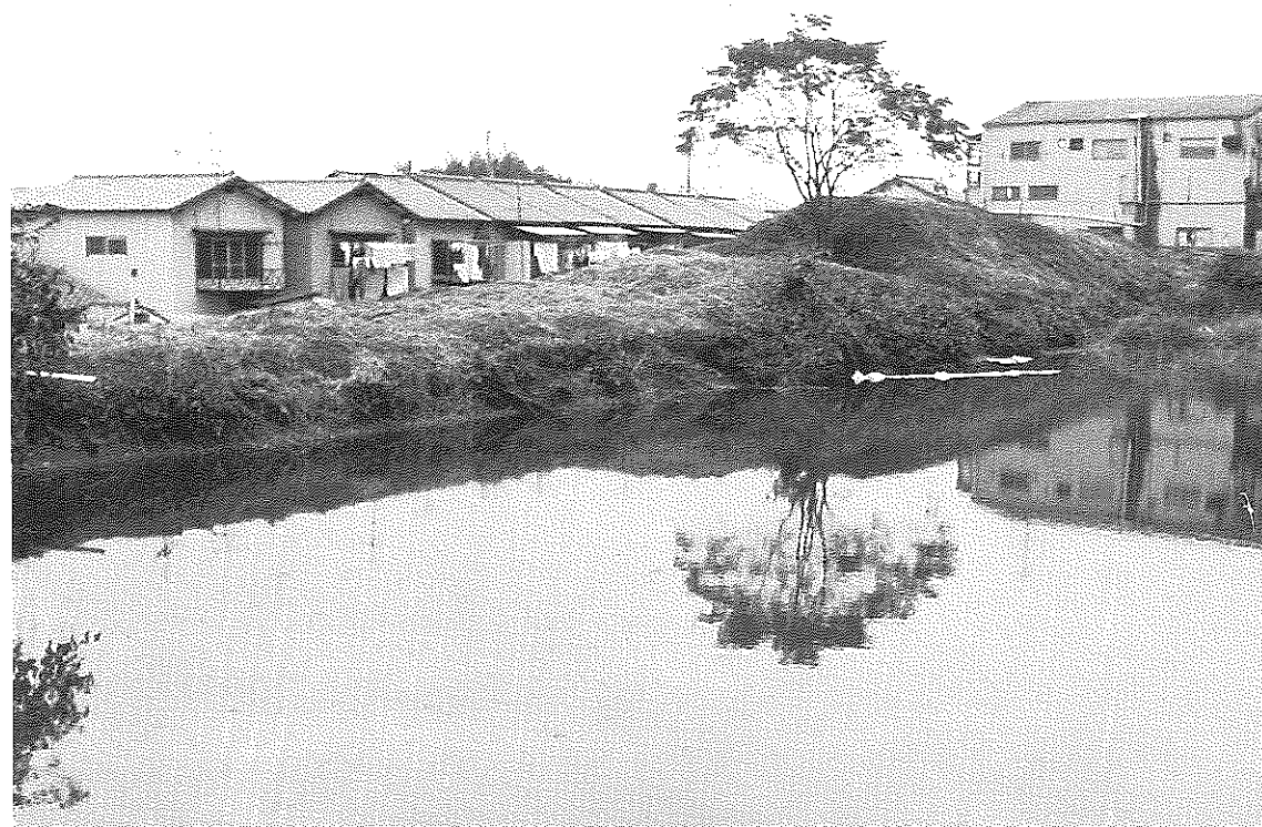
(2) 西側堤の状況 (南東から)
