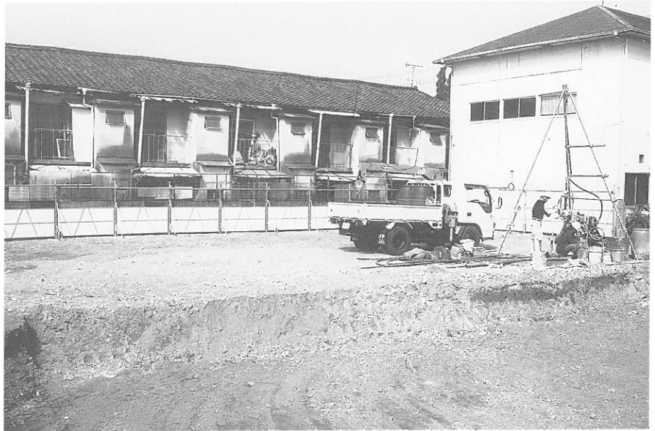
1. 調査前の状況 (南東から)
