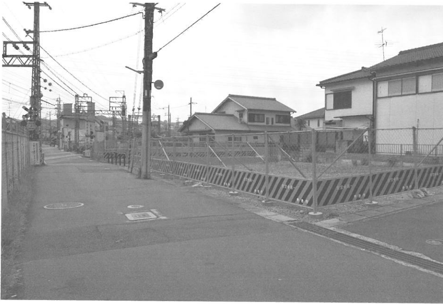
1. 調査地近景 (北から)
