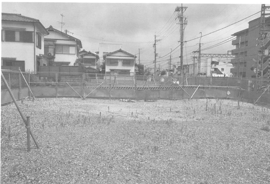
3. 調査前の状況 (南から)
