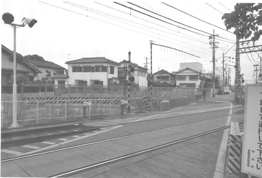
2. 調査地近景 (南東から)
