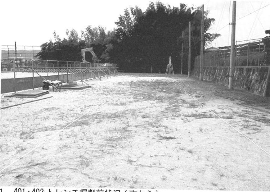
1、401・402 トレンチ掘削前状況(南から)
