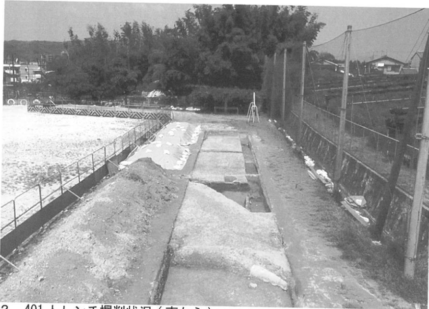
2、401 トレンチ掘削状況(南から)
