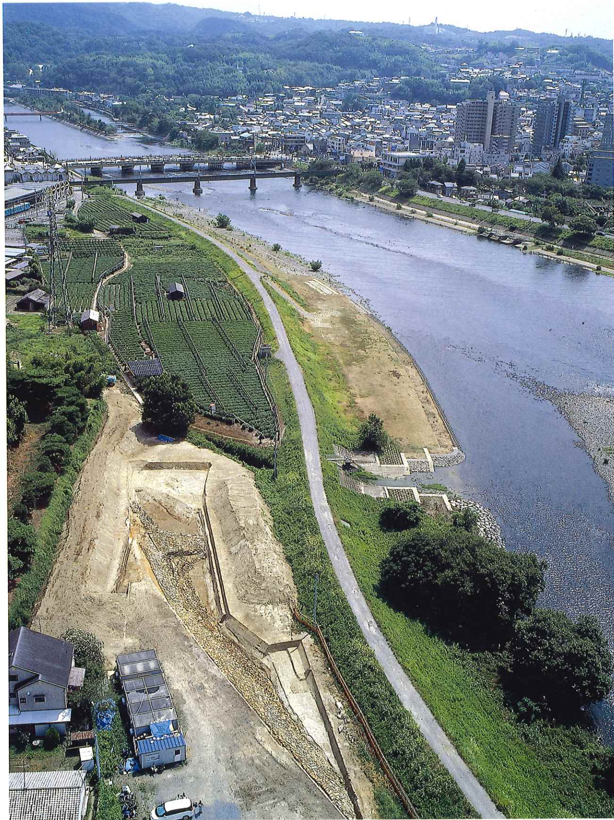
調査地上空写真（北から）
